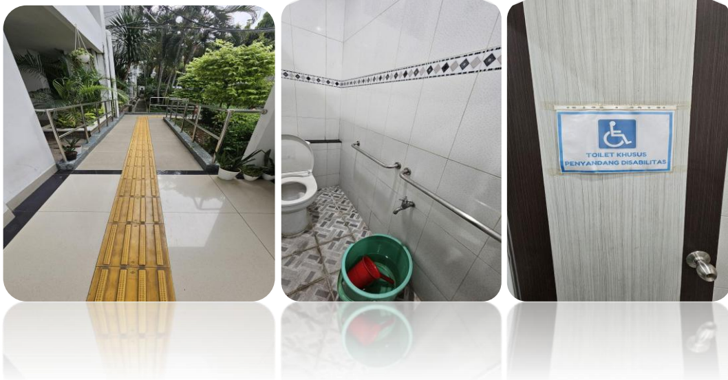
Gambar 11. Sarana disabilitas seperti jalur disabilitas, toilet khusus disabilitas
